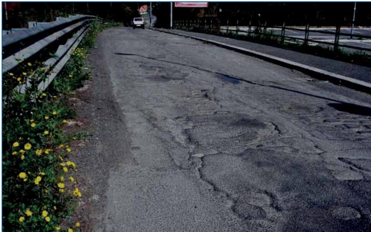
dalle linee bus perché rappresenta un collegamento importante. La situazione non migliora se si attraversano le rampe che collegano il viadotto Gronchi a Colle Salario in entrambe le direzioni. La superficie stradale è in condizioni pessime, è sdruciolevole e cosparsa di buche, le strisce pe-
